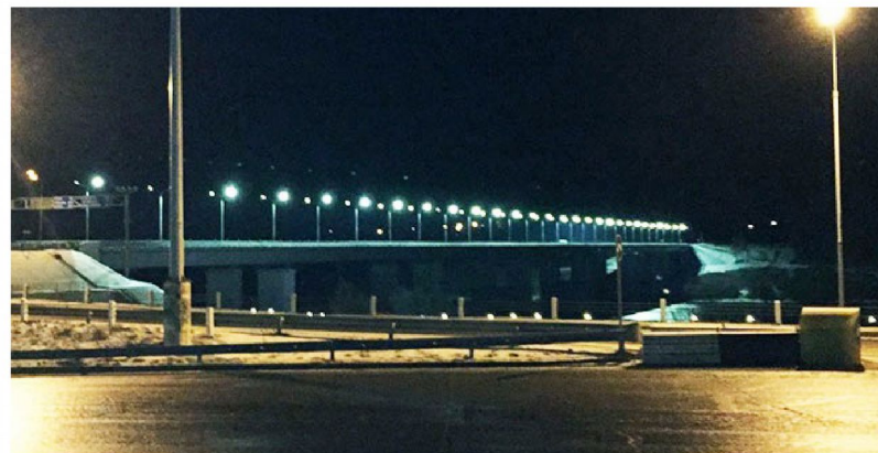
Мост через р. Ока, Калуга
