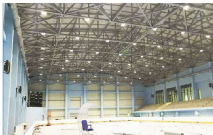
ЛЕДОВЫЙ ДВОРЕЦ (ЕРЕВАН) СИСТЕМА ПОД PLC-УПРАВЛЕНИЕМ. СОВМЕСТНО С КОМПАНИЕЙ «ОПТИМАЛЬНЫЕ ИНЖЕНЕРНЫЕ СИСТЕМЫ». С 2015 Г.
